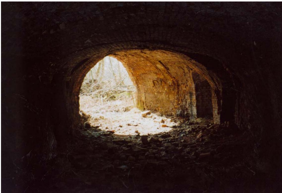
Figuur 16: Licht aan het eind van de tunnel... de ringoven van steenfabriek Klaverland in verval (eigen foto).
