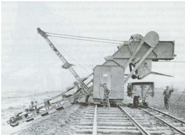
Een excavateur in werking. De klei wordt in een kipkar geladen, die over het smalspoor naar de fabriek wordt geleid (bron: Janssen, 1987).
